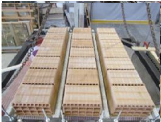
REALIZZAZIONE DEL SOLAIO
