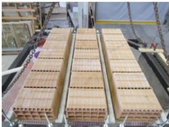
REALIZZAZIONE DEL SOLAIO
