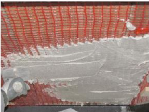
APPLICAZIONE DELL'INTONACO STRUTTURALE
